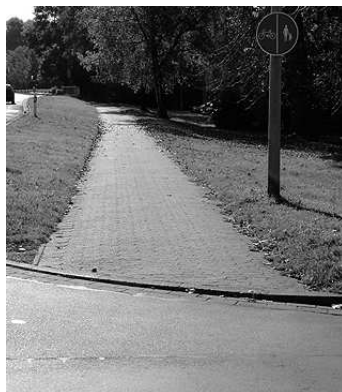
Schlecht abgesenkte Bordsteinkante an der „Langen Straße“
