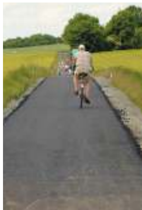
„Nördlicher Okerwanderweg“ nach dem Ausbau
