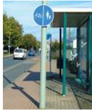
„Halberstädter Straße“ - viel zu schmale Radwege mit inzwischen leider sehr schlechter Oberflächenbeschaffenheit
